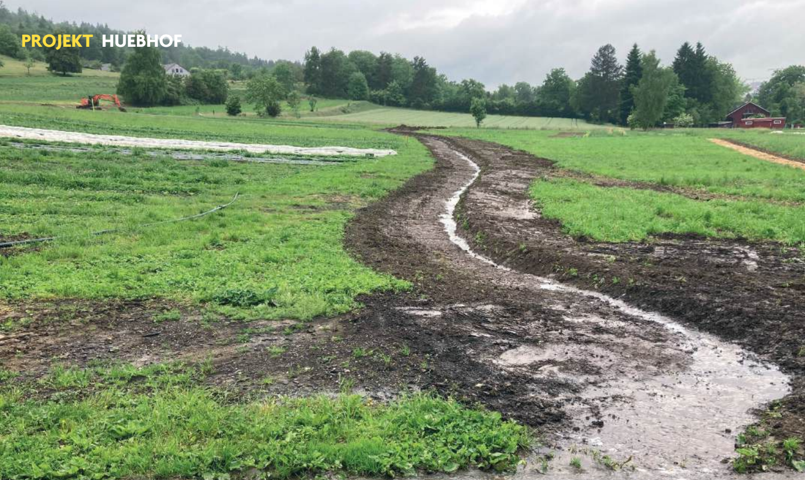
Huebhof, Sommer 2025 : es funktioniert ! Die frisch gezogenen Keyline-Gräben leiten das Regenwasser in die Fläche und verteilen es dort gleichmäßig.
