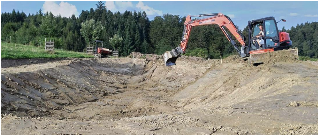
Aushub des Speicherbeckens, September 2024
