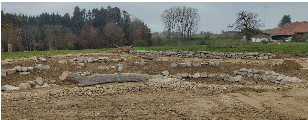
Fertig gebauter Weiher mit Kleinstrukturen, November 2024
