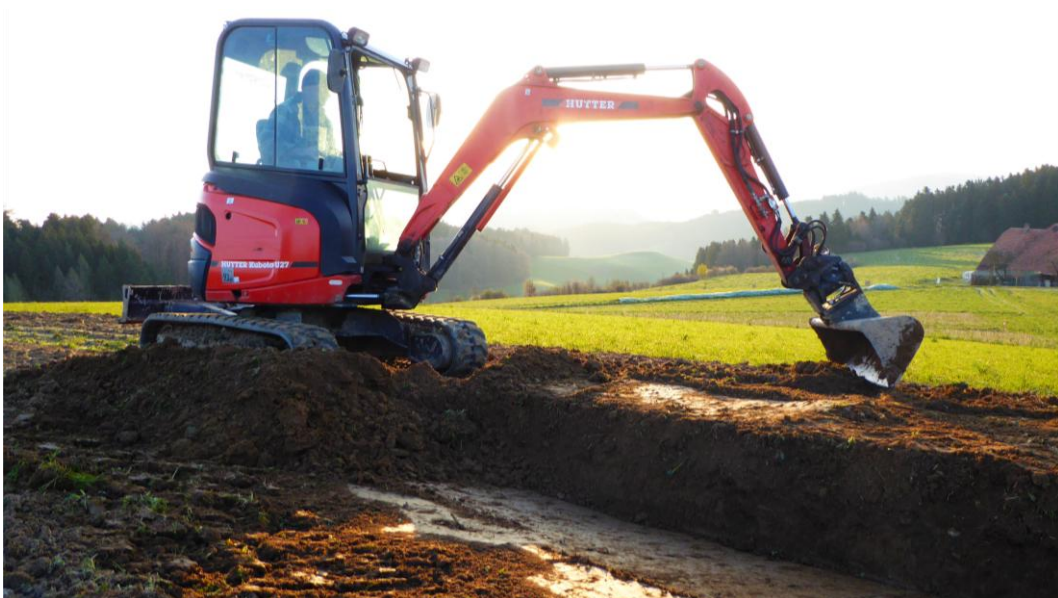
Anlegen der Wassergräben auf der Ackerfläche, April 2023
