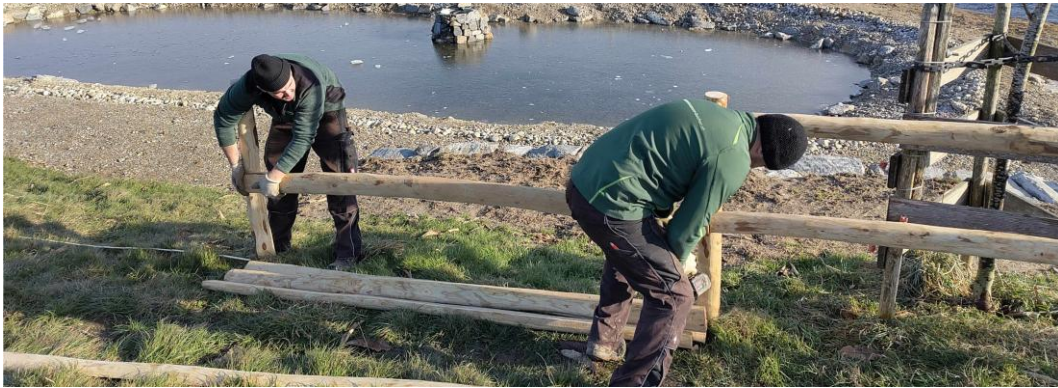
Zaunbau um das Speicherbecken, Januar 2025
