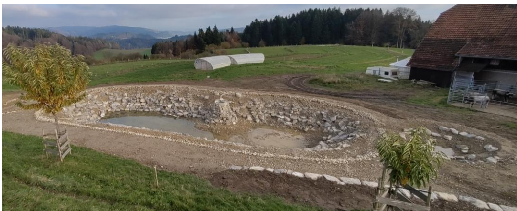
Fertig gebautes Speicherbecken, November 2024
