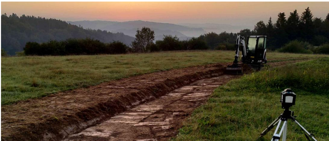
Anlegen der Wassergräben Fläche Ost, September 2023
